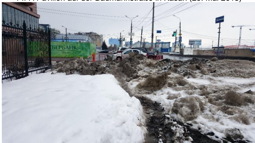
Auf dem Weg zur Stadionbaustelle in Nischni Nowgorod, eigentlich ein Bürgersteig
