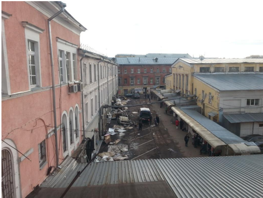
Umbau im Mitnij Rynok. Rechts Stände für Kleidung, links abgerissene Buden, die bis zum Winter durch neue ersetzt werden sollen.
