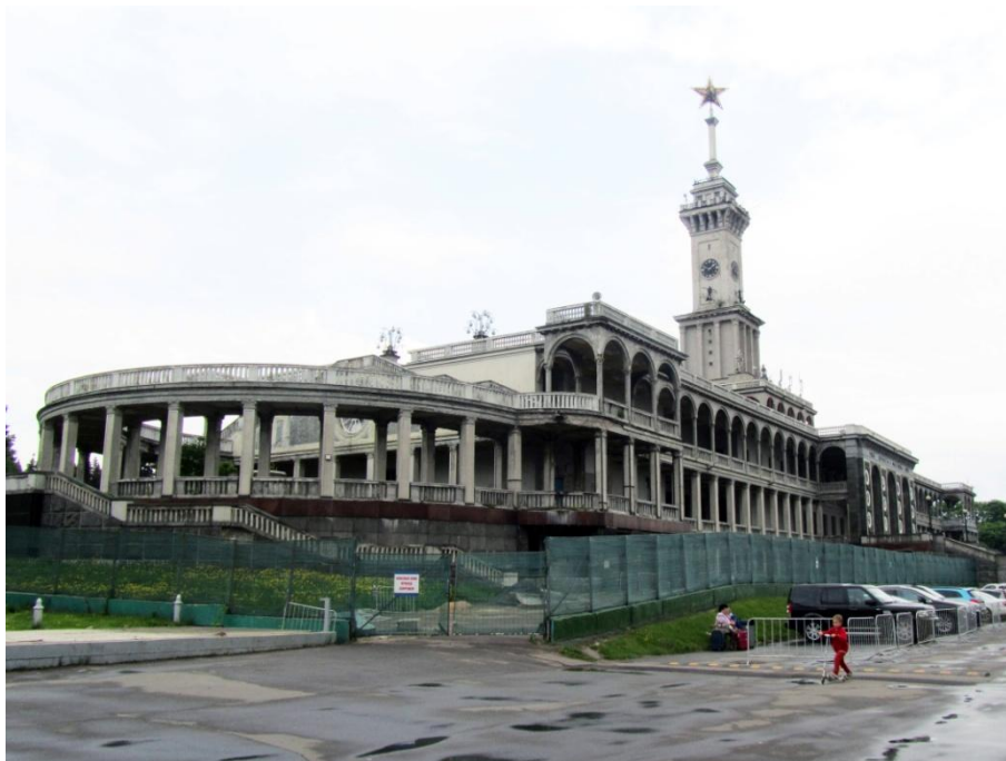
Flussbahnhof in Moskau. Das Gebäude aus den 30er Jahren wird nicht mehr benutzt.
