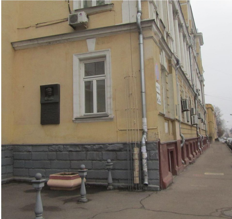
An der Architekturhochschule auf der Ilinskaja fließt das Wasser aus den Fallrohren auf den Bürgersteig
