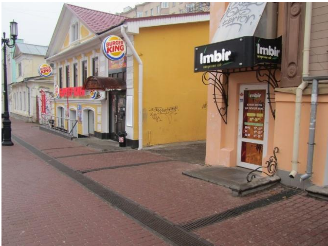
Abgedeckte Regenwasserkanäle an der Bolschaja Pokrowskaja.
